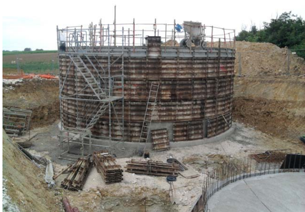
Bassin d'aération et clarificateur en cours de chantier
