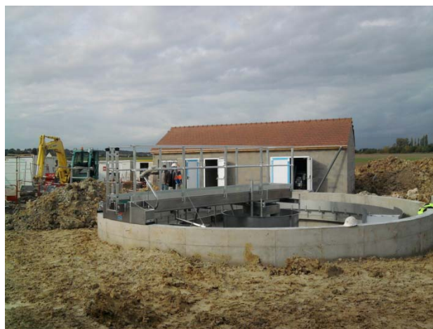
Bassin d'aération et clarificateur en cours de chantier
